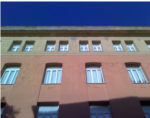
Figura 1: Prospetto principale sud-est
